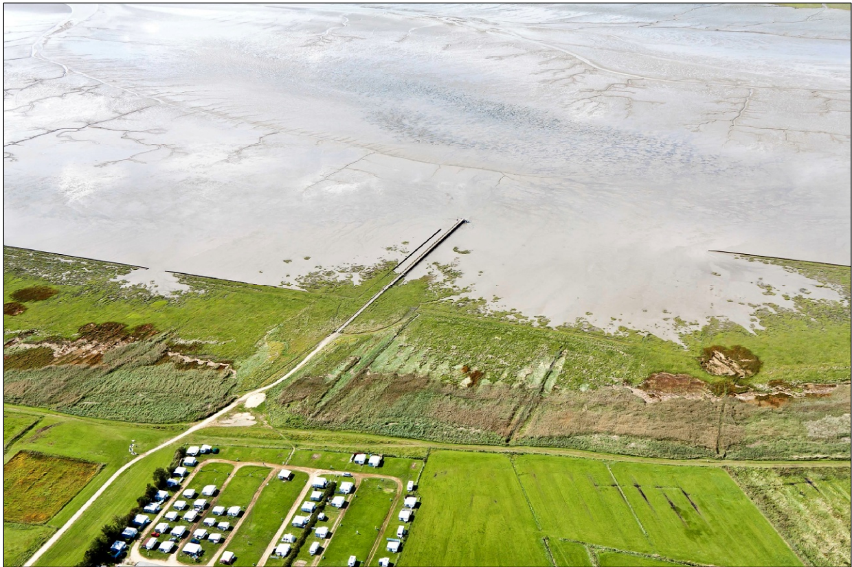
Abb. 4: Der ehemalige Schobüller Strand wird heute von Salzwiesenvegetation bewachsen. Der Campingplatz befindet sich auf einer Geschiebelehmzunge. Foto: Martin Stock, Sept. 2011.
