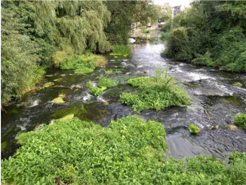
Trave: Blick auf die Sohlgleite an der ehemaligen Mühle
