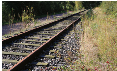
Abb. zu Tab. 59 Alte Gleisanlage bei Hiss-Reet (UG 01.10.2019)
