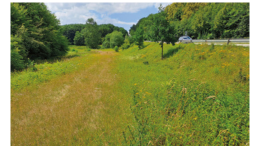
Abb. zu Tab. 56 Regenrückhaltebecken Nr. 30 Kneeden (UG 28.06.2024)
