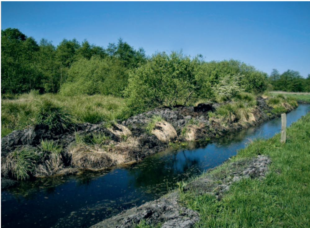
Abbildung 30: Ausbaggerung eines Entwässerungsgrabens an einem Großseggenried/Weidenbruch bei Fleckeby (RD), 2008, Foto: Romahn
